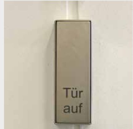
Ein großflächiger Öffnungstaster ist für Menschen mit eingeschränkter Motorik gut zu bedienen
