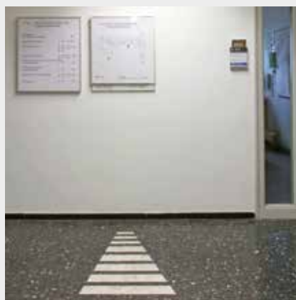
Die Bodenkennzeichnung weist auf Etageninformationen hin, die zusätzlich in Brailleschrift und erhabener Profilschrift ausgeführt sind
