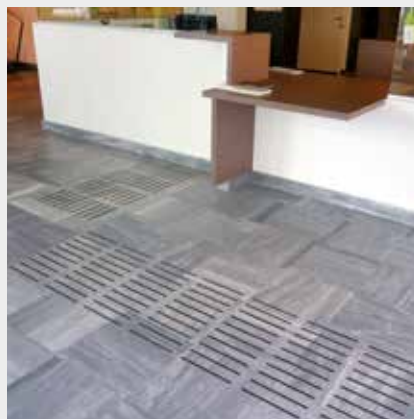
Die linke Tresenseite ist für blinde Menschen mit Hilfe eines Leitstreifens auffindbar
