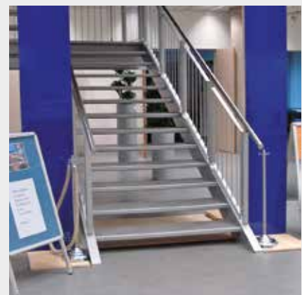
Treppen ohne Setzstufen bergen Unfallrisiken für Menschen mit Geh- und Sehbehinderungen
