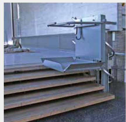
In Bestandsgebäuden kann der Einbau eines Plattformliftes sinnvoll sein, wenn die Treppe ausreichend breit ist
