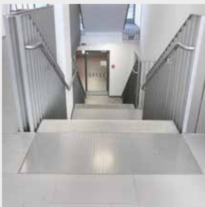
Das Aufmerksamkeitsfeld aus Tränenblech ist gut tastbar und erfüllt auch die Anforderungen an die Rutsicherheit
