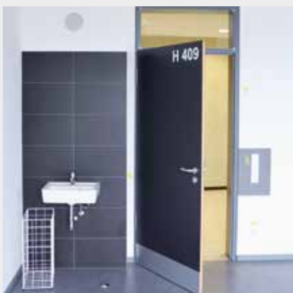
Tür, Raumnummer, Lichtschalter und Waschbecken heben sich kontrastreich von der Umgebung ab
