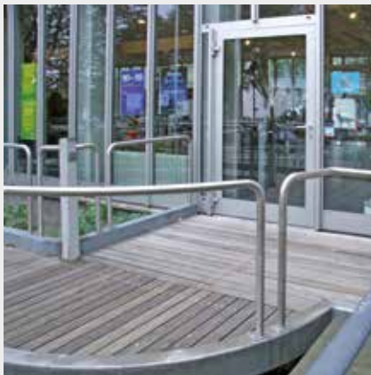
Vor der Tür ist ausreichend Platz für die Betätigung des Türöffners links und zur Begegnung von mehreren Personen mit Rollstuhl oder Kinderwagen
