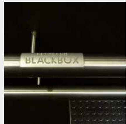
Am Beginn und Ende einer Rampe sind tastbare Hinweise zur Orientierung hilfreich
