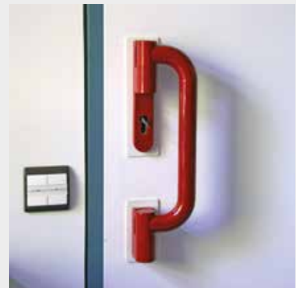
Durch Pressen des Türgriffs kann die Tür auch ohne Greifen entriegelt und geöffnet werden
