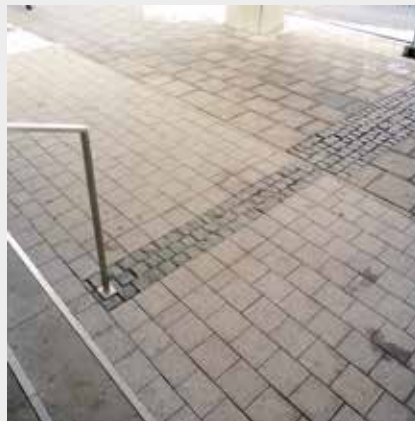
Der Auffindestreifen führt quer über den Gehweg zum Treppenhandauf
