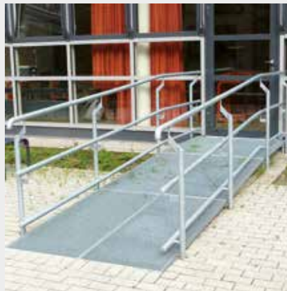
Eine Rampe mit beidseitigen Handläufen und Radabweisern führt zum Klassenraum
