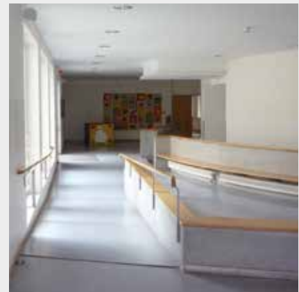
Die Rampe ist auf beiden Seiten mit Handläufen ausgestattet; eine halbhohe Brüstung dient hier auch als Sitzbank
