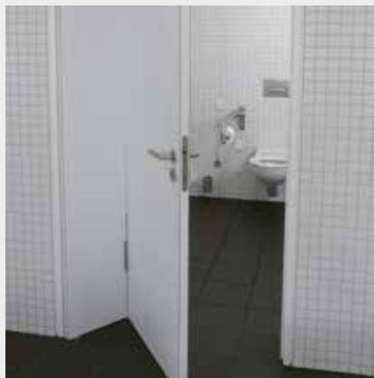
Eine Raumspartür kann vom Rollstuhl aus ohne zusätzliche Fahrmanöver betätigt werden
