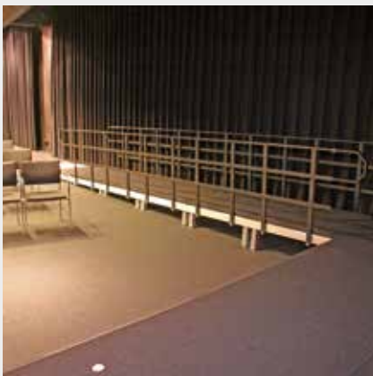
Der Bühnenzugang ist mit Hilfe einer Rampe und beidseitigen Handläufen schwellenfrei möglich
