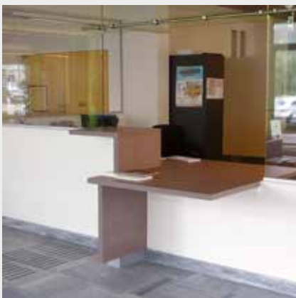
Die rechte Seite des Tresens ist für Menschen im Rollstuhl abgesenkt und unterfahrbar
