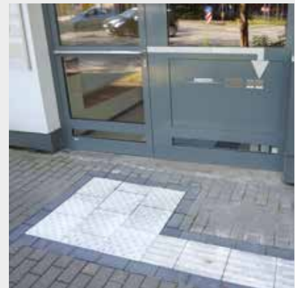
Ein Noppenfeld weist auf die Eingangstür und die rechts angeordnete Klingel hin
