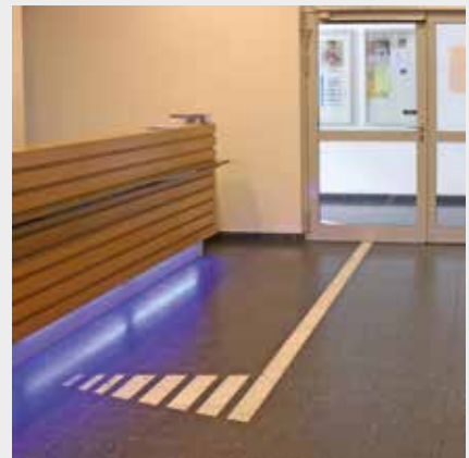
Ein kontrastreicher und taktiler Bodenindikator leitet Besucher vom Gebäudezugang zum Empfang
