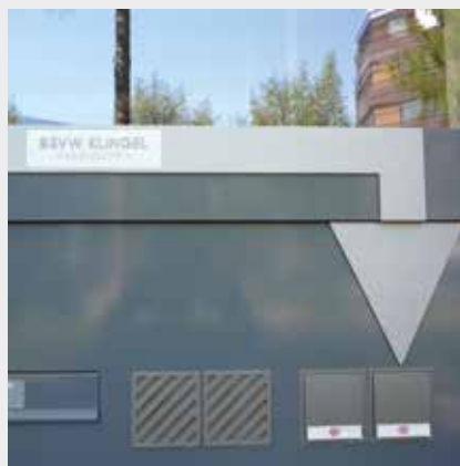
Ein kontrastreicher und taktiler Hinweis-pfeil mit einem tastbaren Schild führen zum Klingeltaster
